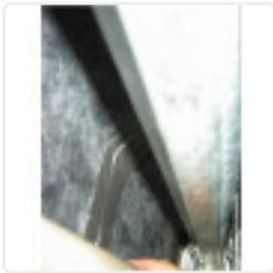
Das Alufixband benötigen bei der Dämmung von z.B. Rolladenkästen. Sie können damit unsere Rolaflexplatten, die Stoß an Stoß liegen, zusammenkleben und schützen so vor Feuchtigkeit und gewährleisten gleichzeitig Stabilität. Ein Alufixband ist 10cm breit, 0,4mm stark und 15m lang.
